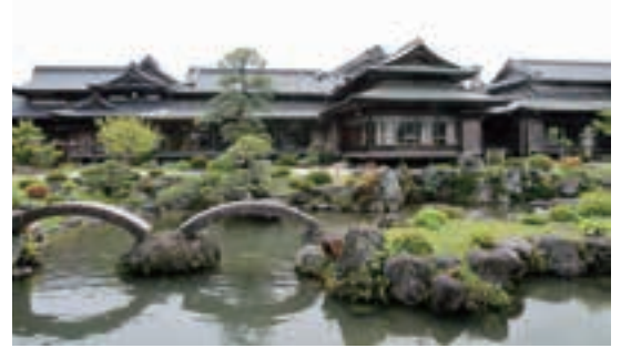
旧藏内邸 池泉庭園と建物群
